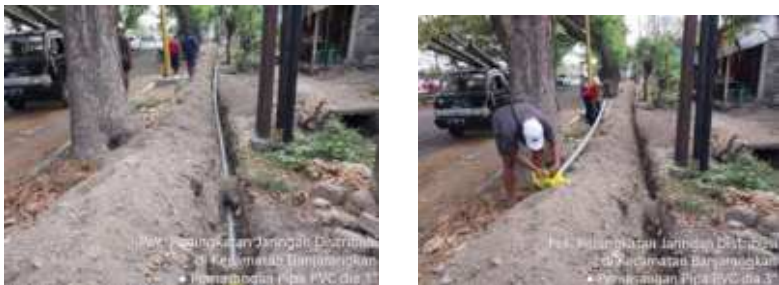
Kegiatan pemasangan pipa dalam rangka peningkatan jaringan distribusi air di Kecamatan Banjarangkan
